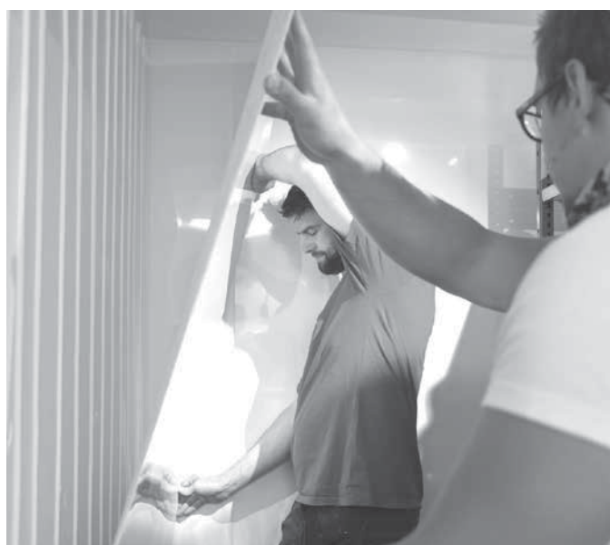
Pose de panneaux Hygi Panel®
